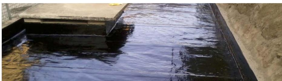
Guaine impermeabilizzanti liquide a base di **Poliurea modificata, applicabili senza impianti specifici**, idonee per sostituire o affiancare molti dei prodotti generalmente utilizzati.
