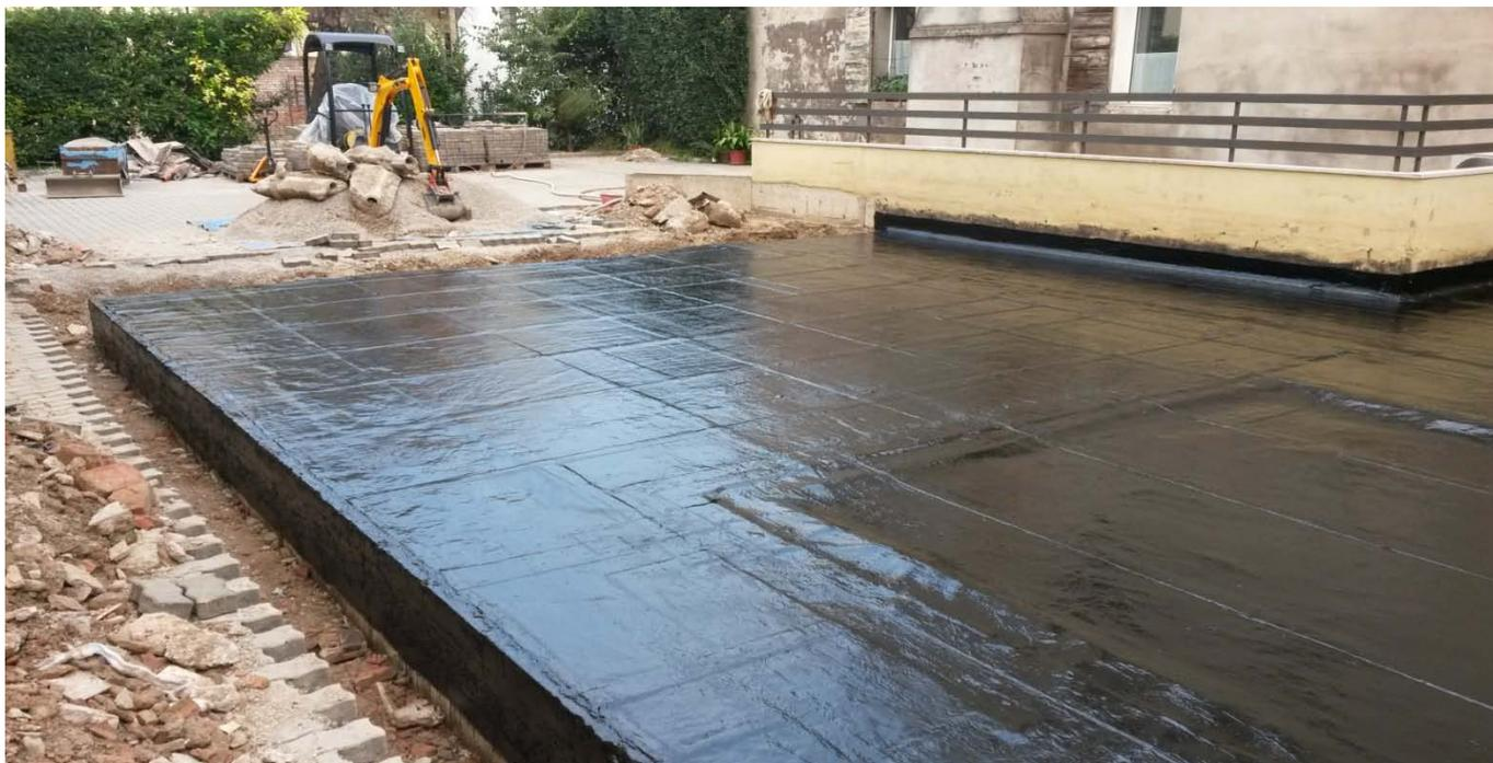
Sulle parti verticali è stata impiegata **black-o-flex** additivata con il 5% di agente tixotropizzante **tix-o-flex**
