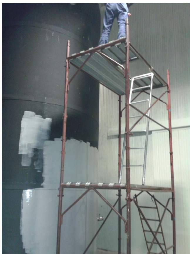
Stesura a rullo della membrana liquida e particolare dell'intervento
