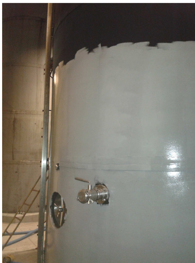
Stesura a rullo della membrana liquida e particolare dell'intervento
