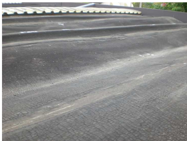
Dettaglio dello stato della membrana bituminosa
