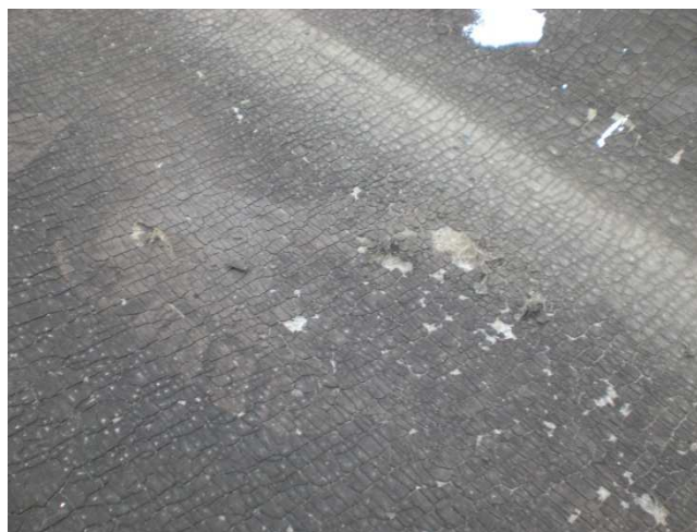
Dettaglio dello stato della membrana bituminosa
